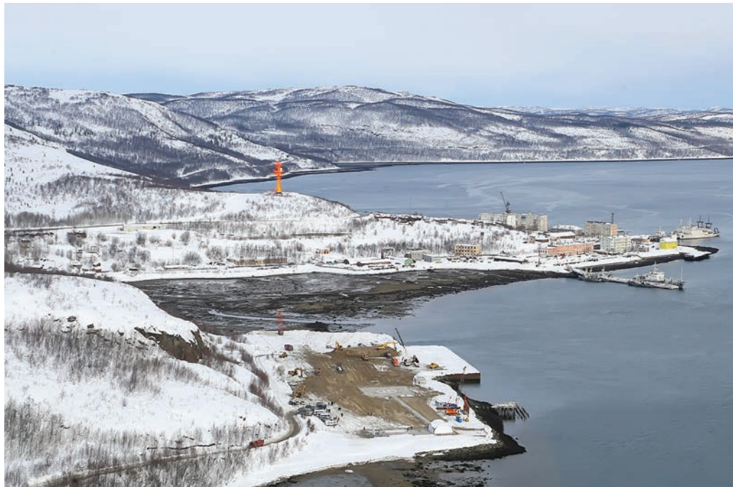
СТРОИТЕЛЬСТВО ТЕРМИНАЛА «ЛАВНА». ФОТО С САЙТА WWW.SDELANOUNAS.RU
